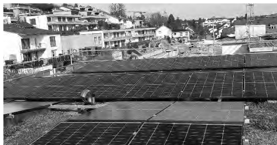
Mit einem virtuellen Zusammenschluss zum Eigenverbrauch (ZEV) des Solarstroms dürfen Liegenschaften, die über einen gemeinsamen Anschlusspunkt zum Versorgungsnetz verfügen, seit diesem Jahr die bestehenden Stromleitungen zur Stromverteilung innerhalb des ZEV nutzen (Foto: Mehrfamilienhaus Müllheim).
